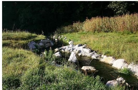
Umgehungsgerinne Obermühle, Oberrot
