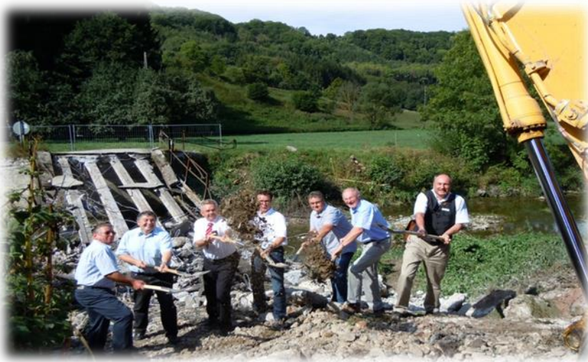
Erster Spatenstich in der Flurneuordnung Wolperts- hausen (Bühlertal).
