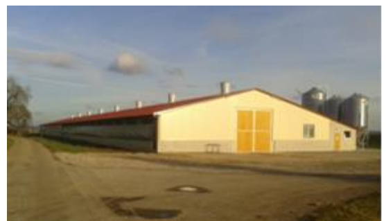
Bild: Neubau eines Putenmaststalls
