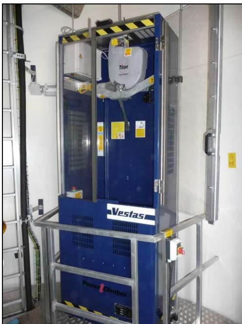
links: Aufzugsanlage in einer Windkraftanlage, rechts: Anfahrtschutz an einer Flüssiggastankstelle
