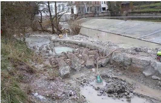
Hellersche Mühle, Schwäbisch Hall - Umgehungsgerinne im Bau
