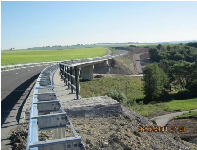
Grundbachbrücke bei Wackershofen (BW 7) Süd-/Nordrichtung
