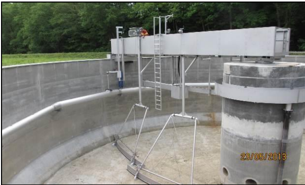
Probelauf Nachklärbeckenräumer
