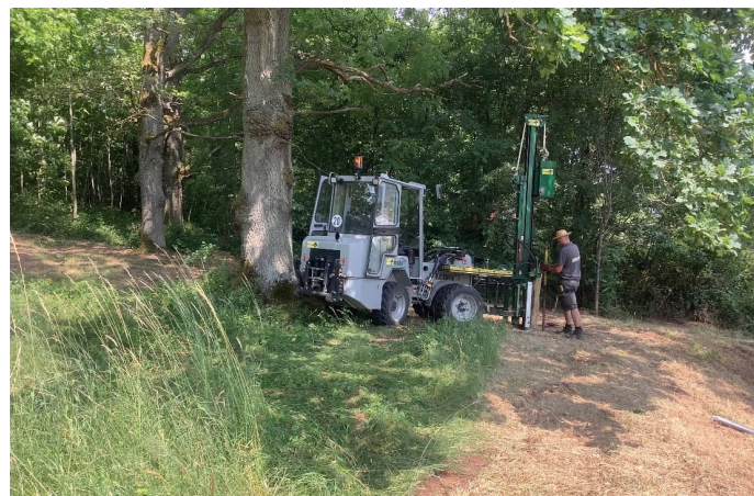
Die beauftragte Firma setzt die ersten Pfosten des Festzauns
