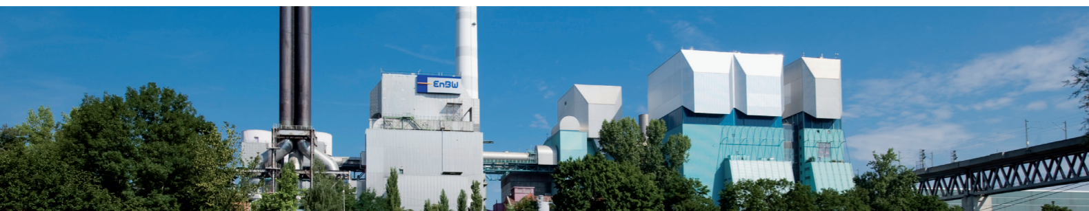
Restmüllheizkraftwerks Foto: EnBW Kraftwerke AG
